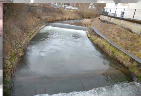
Abb. 1: Zwei Sohlenabstürze oberhalb der Postbrücke unterbrechen die aquatische Längsdurchgängigkeit der Röhre.
