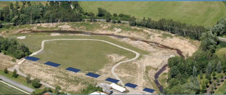
Aus der Vogelperspektive zeigt sich der neue Losseabschnitt in seiner ganzen Länge; der frühere kanalisierte Verlauf (gestrichelte Linie im Vordergrund) wurde mit Teilen der anfallenden Aushubmassen verfüllt. (Luftbild: Ernst Bohnhardt)
